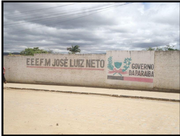
Figura 1 - Fachada da E.E.E.F.M. José Luiz Neto/ Barra de Santa Rosa/PB. Fonte: SANTOS, 2014
